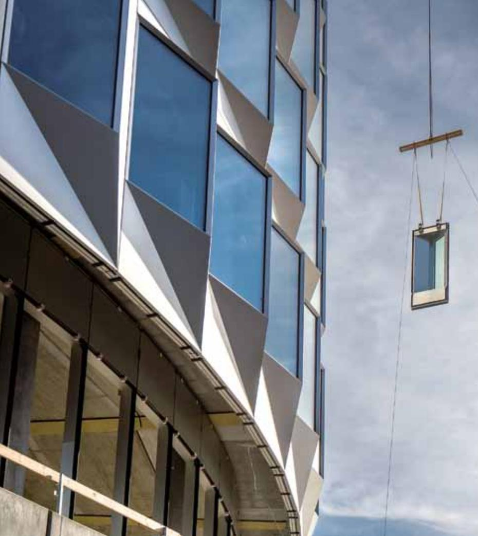
Umfangreiche Tageslichtanalysen sind die Grundlage für die Fassadengestaltung des Bürogebäudes „Redmolen“. Der 60 Meter hohe Bau am Eingang zum Kopenhagener Hafen trägt eine rund 12.000 m<sup>2</sup> große Elementfassade, deren Neigung das Tageslicht je nach Bedarf filtert. Das 3fach-Isolierglas besteht aus hochtransparentem Sonnenschutzglas COOL-LITE SKN 176 und Tageslichtglas ECLAZ von Saint-Gobain Glass.
