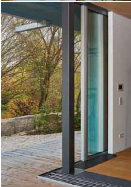
Mit dem Schiebefenster cero wird eine Verglasung über Eck realisiert, die sich komplett öffnen lässt.
